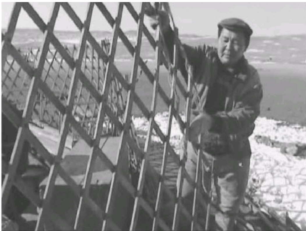
06 拆除蒙古包帷幔支架。
