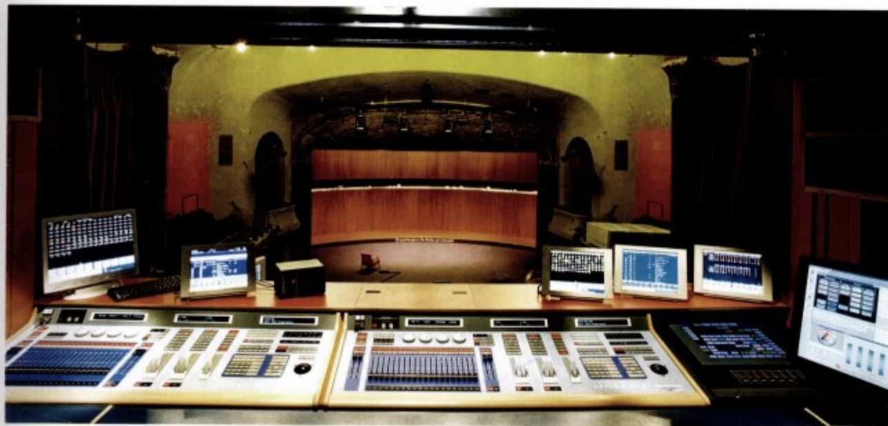
图379 灯光控制室，慕尼黑室内剧院。双Transtech Prisma NTX控制台，Linux系统，最多高达16384通道（常规灯、换色器和电脑灯），AVAB、ETCNet2和Artnet协议。Transtech Digiplus用于工作和排练灯光，19英寸触摸屏运行Transtech Libra（用户可配置图形界面，用于NT/NTX）以及SNMPc网络管理，管理所有网络节点。
