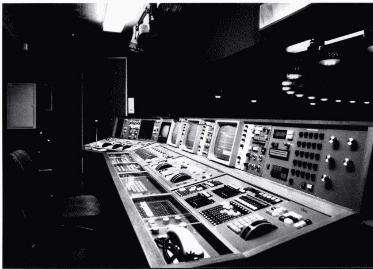
图403 640个通道的大型灯光控制台。系统：Lightboard，1932年。
