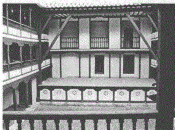
图 6.4A 阿尔马格罗(位于城市市场附近)的庭院剧场,建于 1628 年。这是 1953—1954 年恢复之后的情形。舞台为 28 英尺宽,13 英尺深,它一直延伸到舞台的后排柱子处,那里有一道从楼座上垂下的帷幕。而从后排柱子到后墙上的门,之间的距离为 2 英尺 8 英寸。照片由 F. J. 希尔蒂拍摄。
