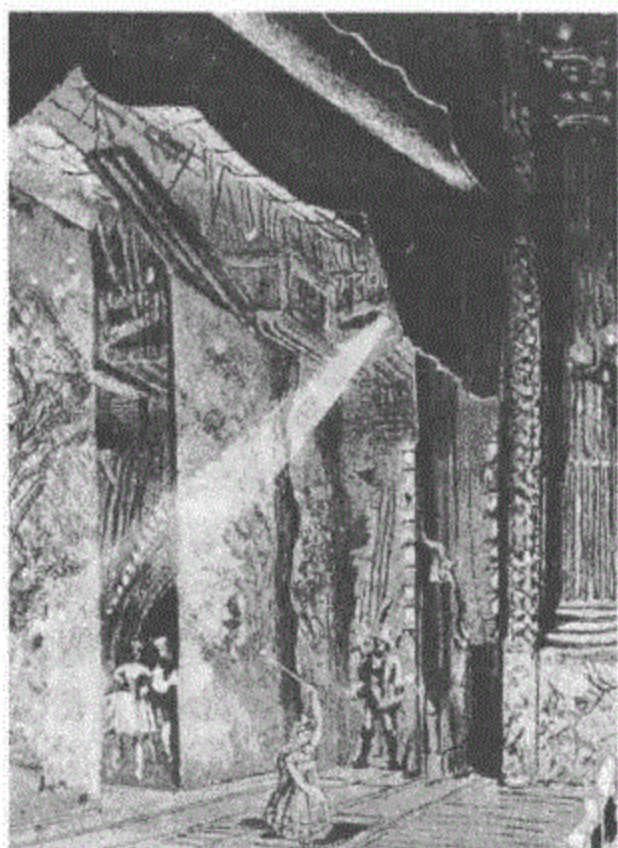
图 14.25 十九世纪后期的一个英国舞台。注意舞台的地面是如何分开的；还请注意下沉的机关，顶端的沟槽和强烈的（石灰灯或碳弧）光柱。最下端右角可以看见脚灯，作为舞台画框之后的一排垂直的灯光。选自《艺术杂志》(1889)。
