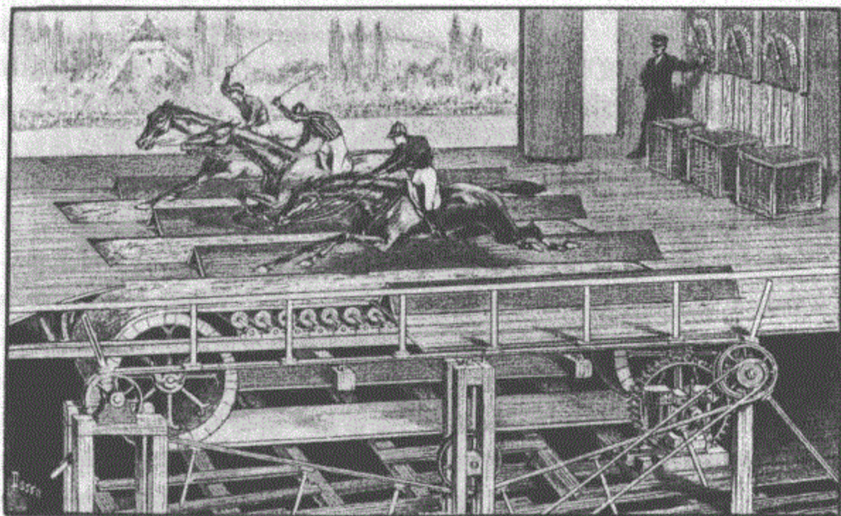
图 14.26 舞台上的赛马，使用移动的全景布景和电动马达驱动的踏车，速度由右上角的人操控。1889—1890 年纽约协和广场剧院。选自乔治·莫奈的《剧场机械》(1893)。
