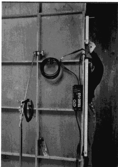
图1-4 一名剧组工作人员在安装灯光设备。
