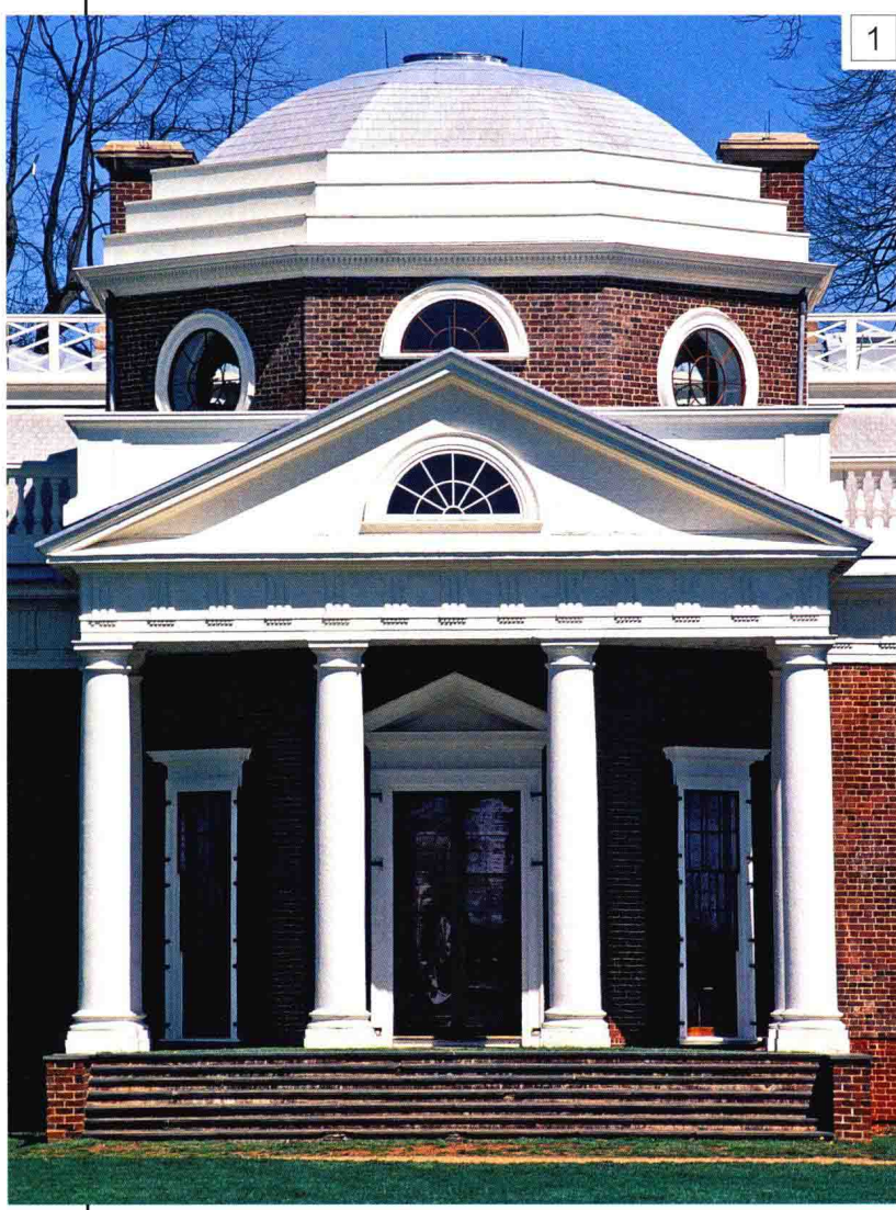
▲ 西门廊 蒙蒂塞洛庄园的东西两侧门廊造型相同，都是由一排白色的多立克圆柱支撑起三角山墙。与古希腊多立克柱式（见第 23 页）不同，这些圆柱柱身上没有凹槽，但是却多了柱础。较早建成的东门廊是用石头砌成的，但是由于缺少能干的石匠，后来建造西门廊圆柱时，杰斐逊选择使用了特制的曲面砖。
