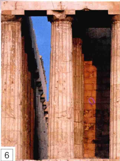
▲ 柱廊 在神庙的柱廊中，转角处的柱子间距略微小于其他位置的柱子间距。这种细微的不规则设计使得建筑正面看起来更富于变化和韵律感。
