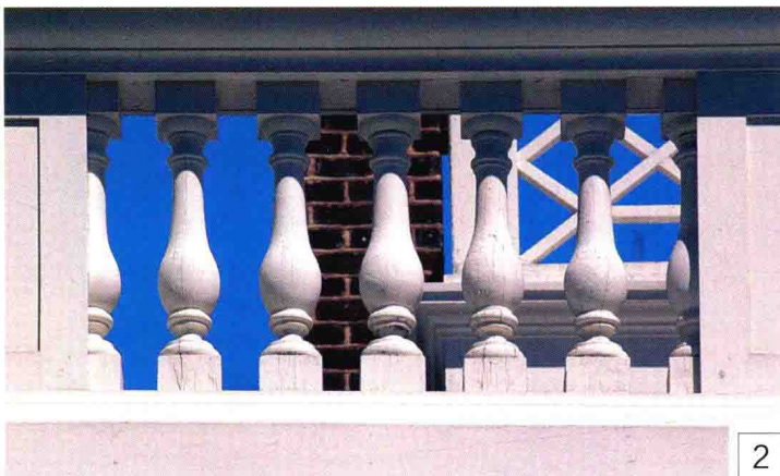
▲ 古典细部 18、19 世纪的新古典主义建筑师们在进行设计时往往会围绕某种元素展开，如从古希腊和罗马建筑中吸取的圆柱和山墙。他们也会加入一些自己独创的元素，比如这种隐藏起整个屋顶的女儿墙。不同于一些建筑师倾向的实心女儿墙，杰斐逊将女儿墙设计为成排栏杆柱，不仅增加了视觉趣味，而且使得结构看起来更加轻盈。
