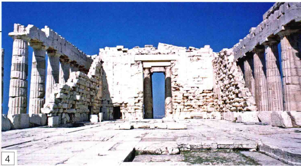
▲ 神庙内部 在外围环形柱子之内，用墙围住的神庙内部被分隔为两个独立空间。较大的一间位于建筑东端，长约30米，其中竖立着菲狄亚斯创作的宏伟的雅典娜神像，高达12.8米。在这个房间的三个边上又围绕了一圈柱子，但是时至今日，除了端墙和高大的入口，其余部分已经损毁殆尽。
