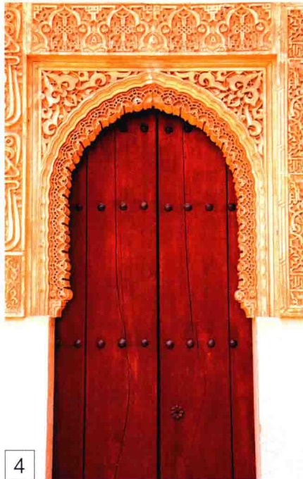
▲ 拱门 西班牙伊斯兰教风格建筑师们常常采用若干种尖券，如图中所示的这种香桃木院中的拱券，拱的两侧边笔直而高挑，拱顶弧线较平滑。拱券周围雕刻着复杂的图案，金银丝细工装饰渗透到了拱的曲线，因此拱券的边缘在这些装饰细节中略显模糊。
